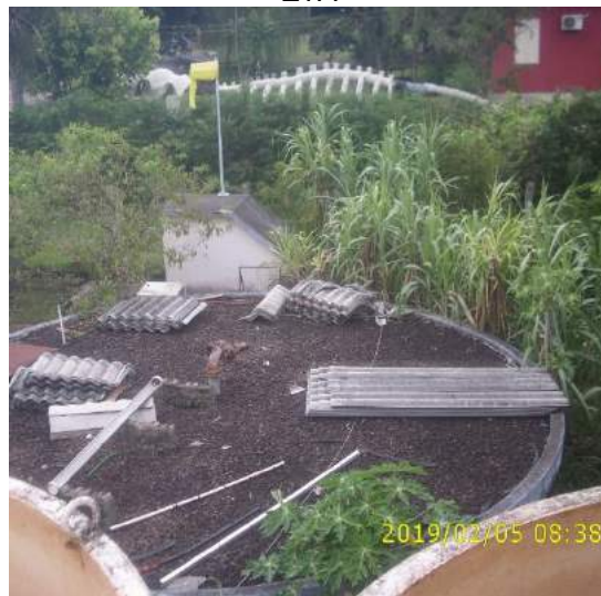
Figura IV.47 – Reservatório semienterrado da ETA
