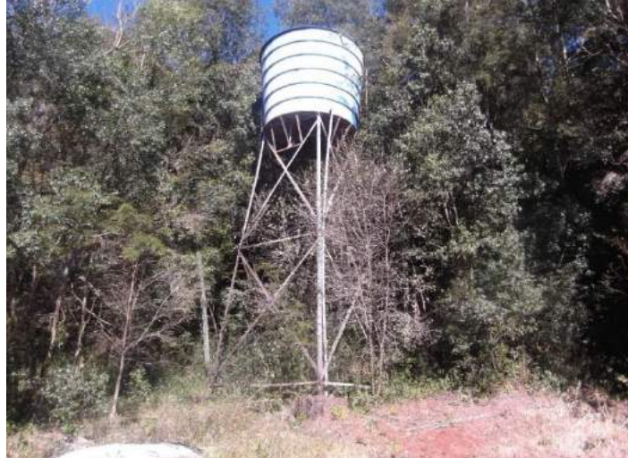
Figura IV.125 – Reservatório da Linha Castelo Branco
