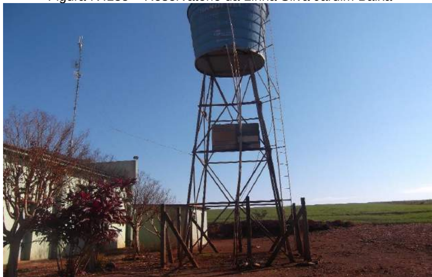
Figura IV.135 – Reservatório da Linha Silva Jardim Baixa
