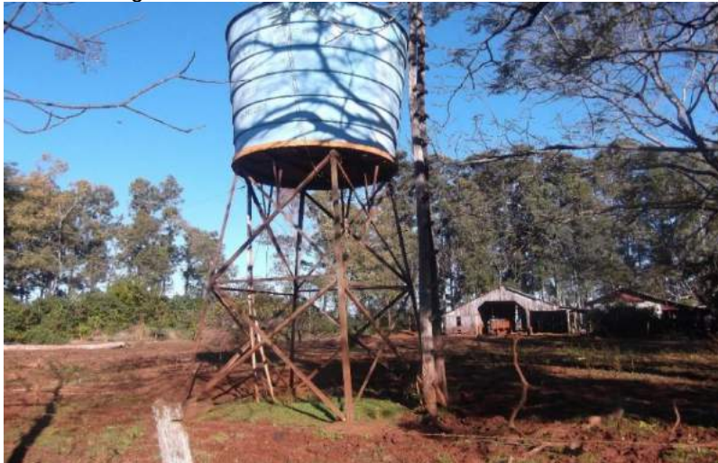
Figura IV.119 – Reservatório da Linha Abrantes
