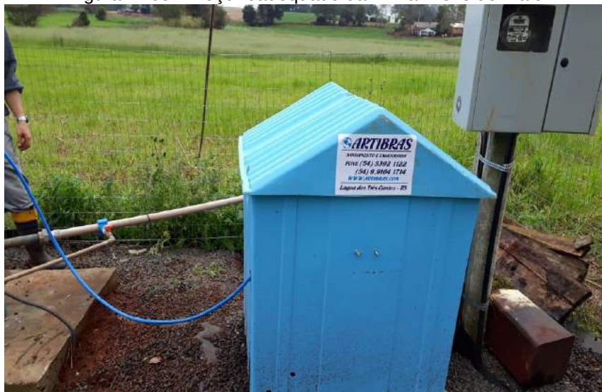
Figura IV.63 – Poço readequado da Linha Treze de Maio
