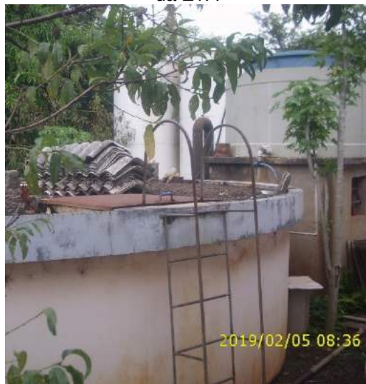
Figura IV.46 – Reservatório semienterrado da ETA
