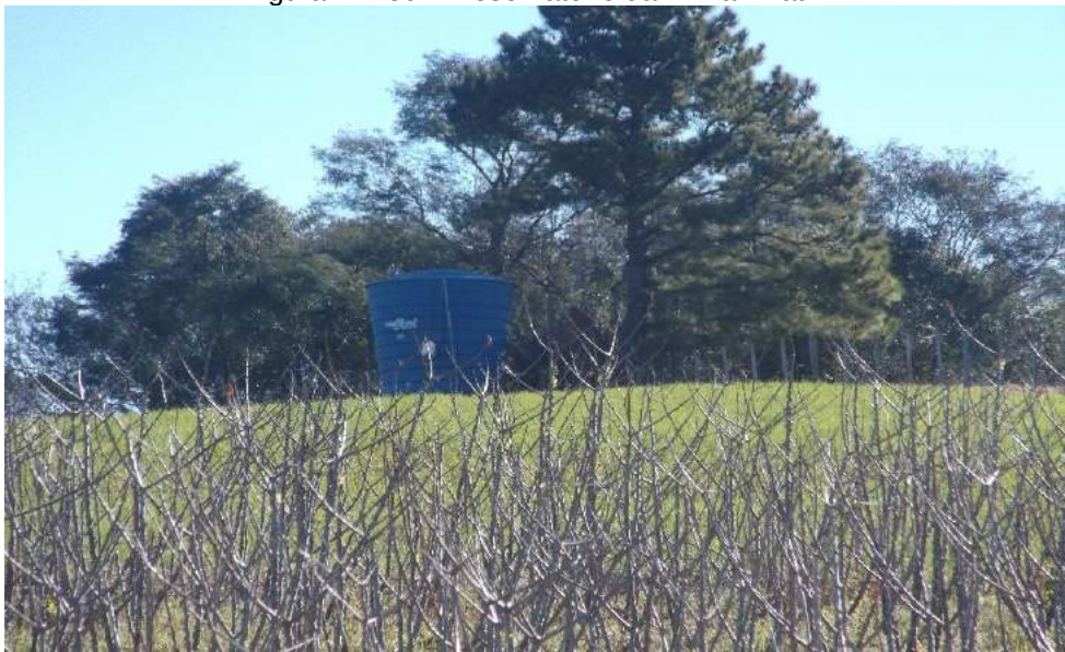
Figura IV.130 – Reservatório da Linha Piratini
