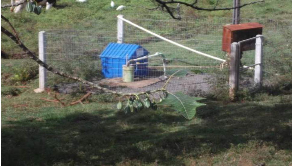
Figura IV.78 – Poço readequado da Linha Esquina União (Elmo)
