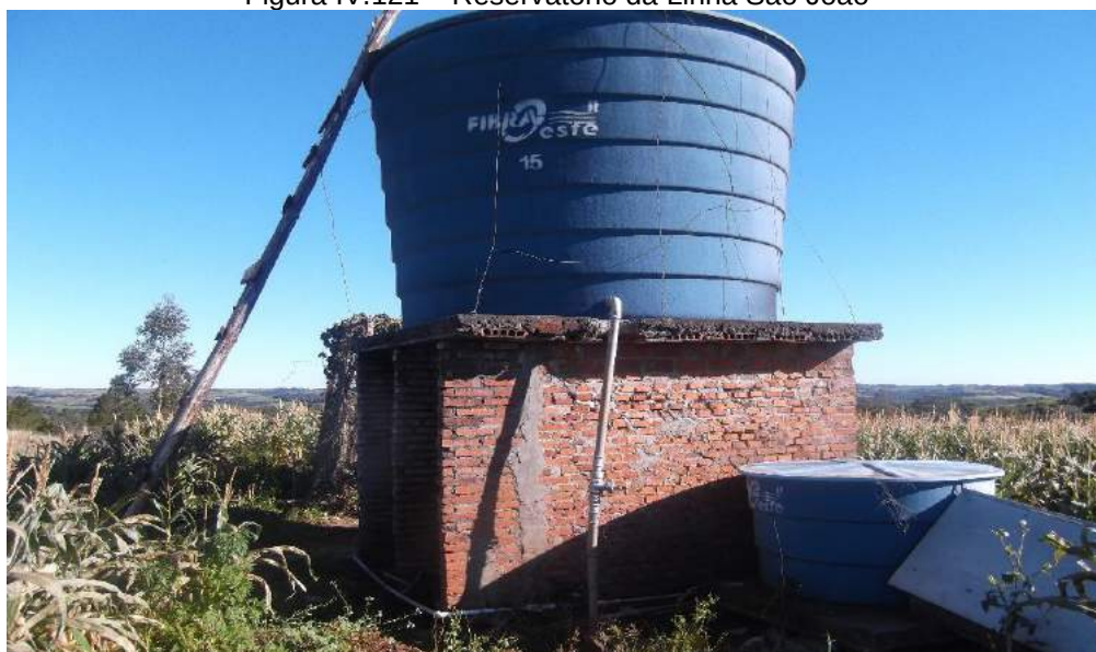
Figura IV.121 – Reservatório da Linha São João
