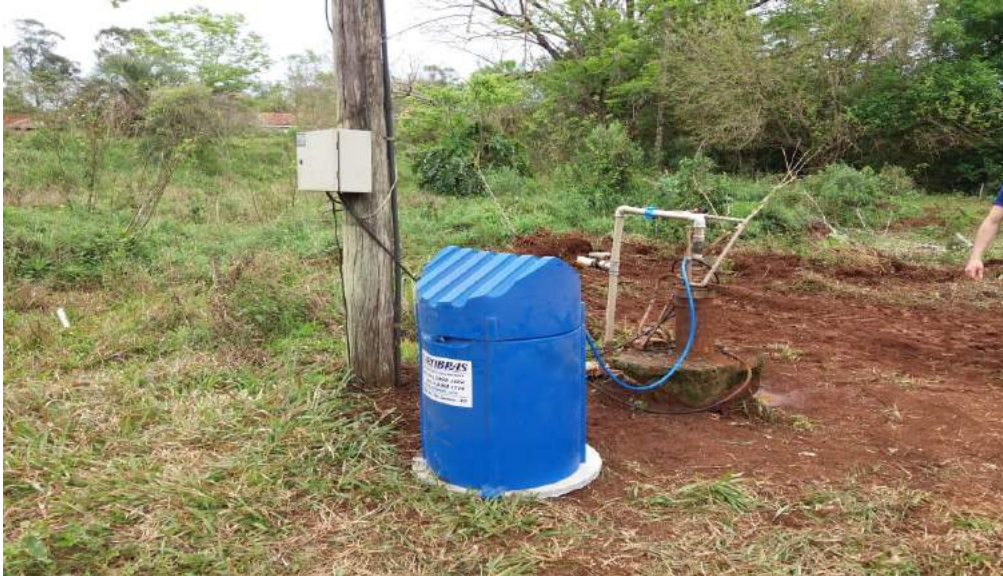
Figura IV.108 – Poço readequado da Linha dos Louros
