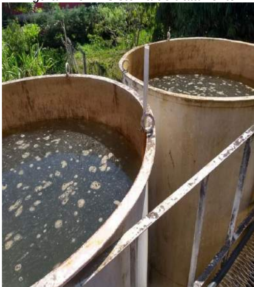
Figura IV.34 – Sistema de tratamento
