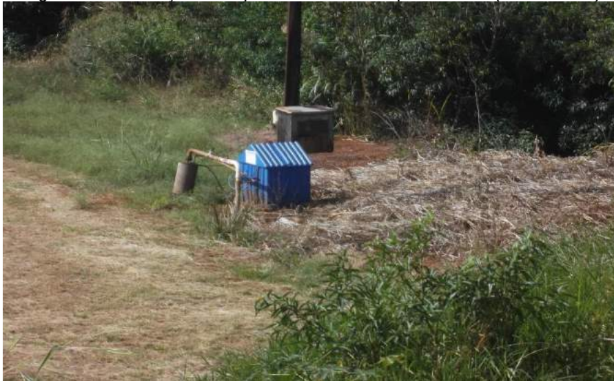
Figura IV.79 – Poço readequado da Linha Esquina União (Luiz Kunkel)
