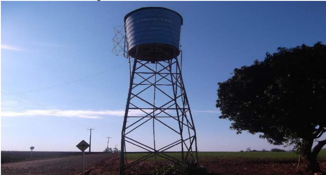
Figura IV.138 – Reservatório da Linha Acre
