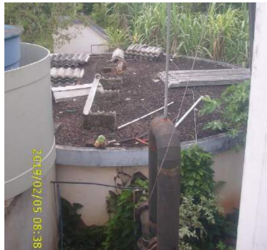
Figura IV.49 – Reservatório semienterrado da ETA
