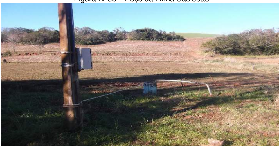
Figura IV.66 – Poço da Linha São João
