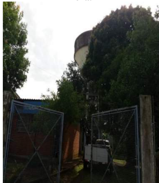
Figura IV.43 - Reservatório água vista frontal
