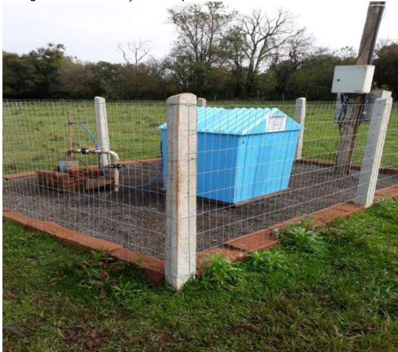
Figura IV.102 – Poço readequado da Linha Dr. Pedro de Toledo
