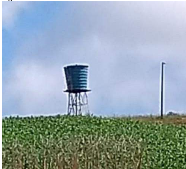
Figura IV.129 – Reservatório da Linha São Bonifácio
