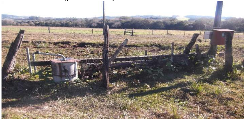
Figura IV.80 – Poço da Linha São Bonifácio
