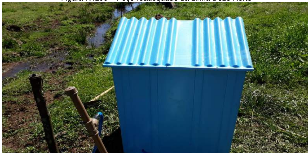
Figura IV.100 – Poço readequado da Linha Doze Norte
