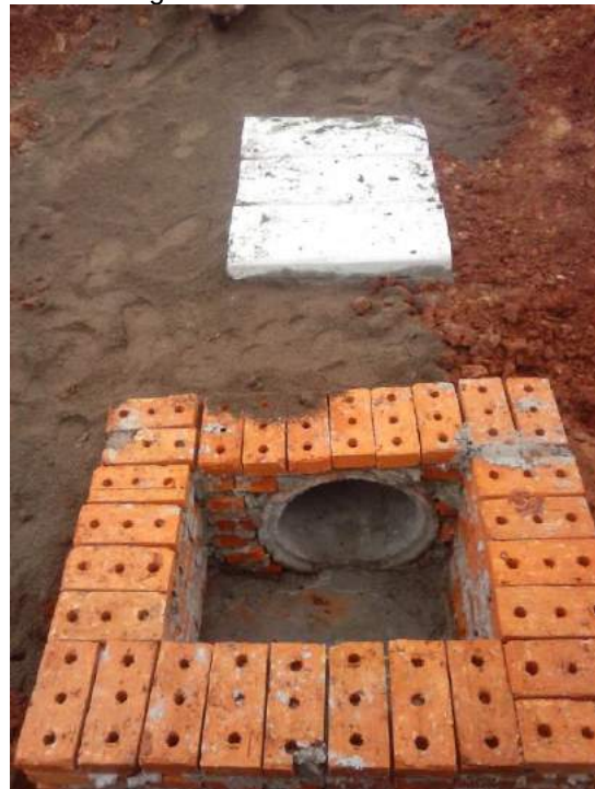
Figura IV.198 - Reforma na rede de drenagem da Rua Loureiro da Silva
