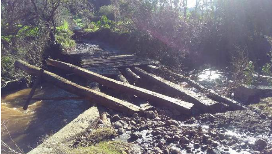
Figura IV.207 - Estrutura de pontilhão na Linha Piratini, em maio de 2017
