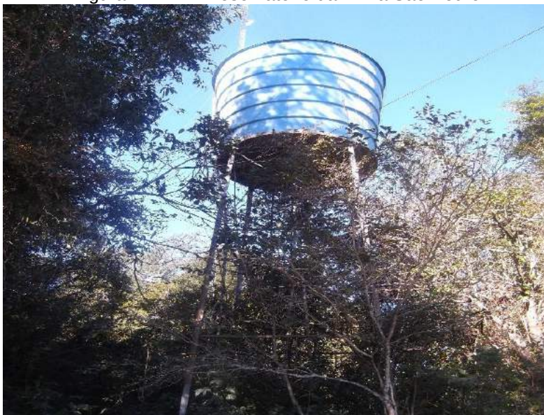
Figura IV.142 – Reservatório da Linha São Pedro
