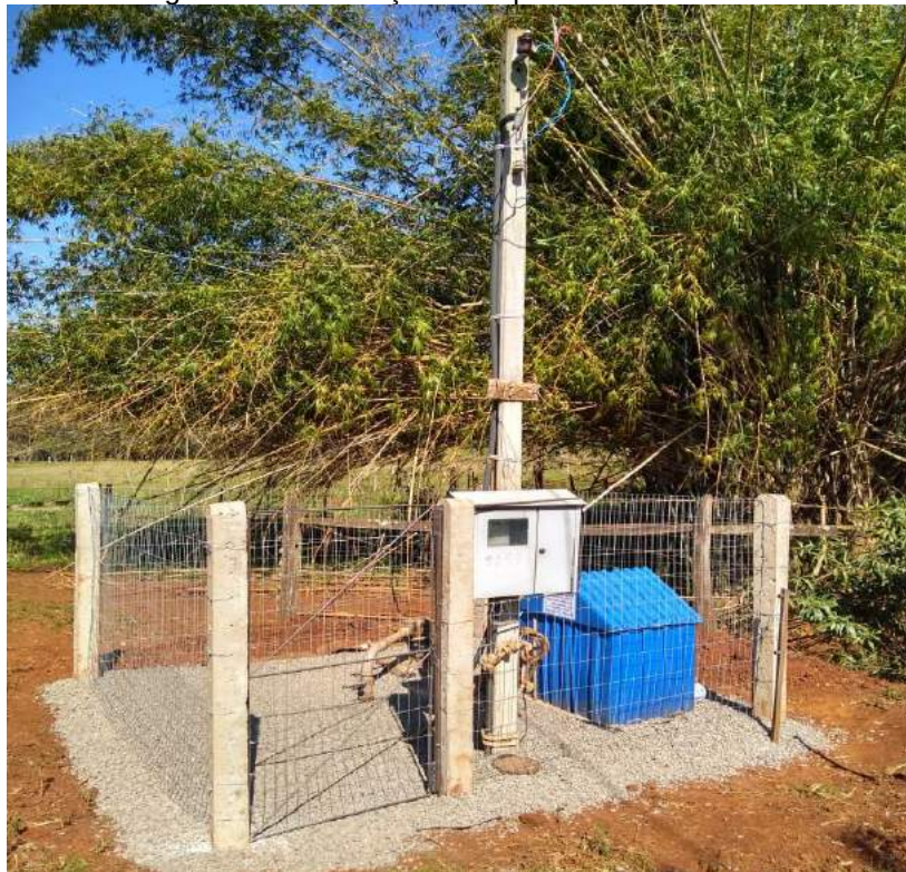
Figura IV.117 – Poço readequado da Linha Natal
