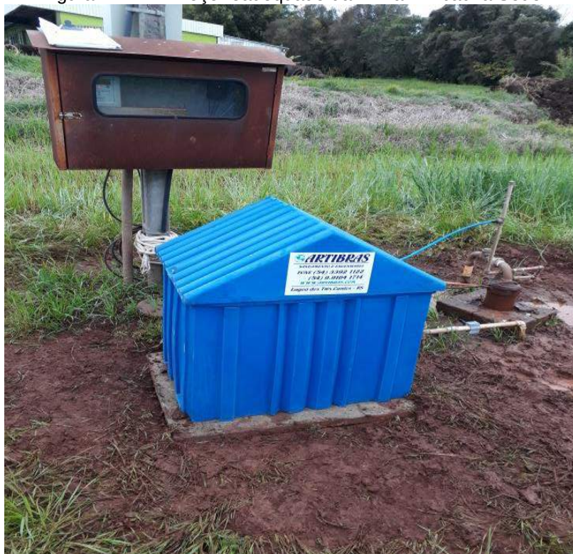
Figura IV.111 – Poço readequado da Linha Timbaúva Sede
