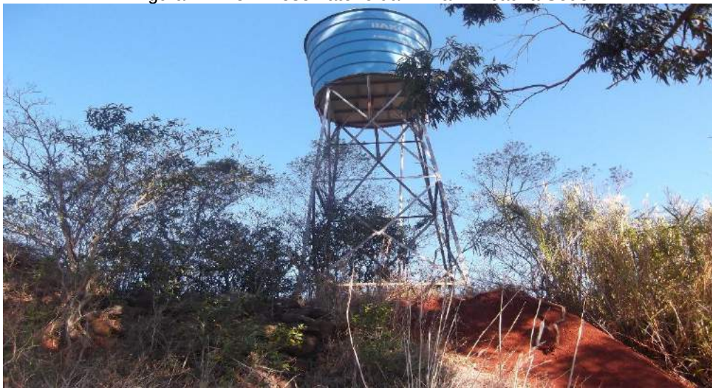
Figura IV.145 – Reservatório da Linha Timbaúva Sede
