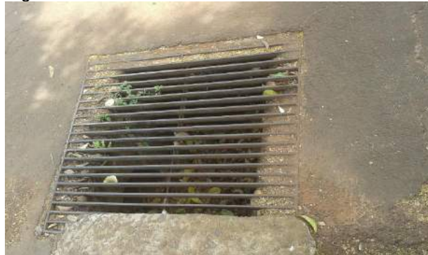
Figura IV.187 – Boca de lobo da Rua Dom Hermeto
