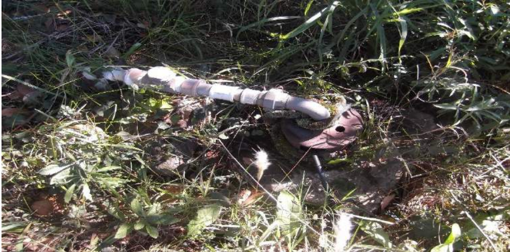
Figura IV.72 – Poço da Linha Castelo Branco
