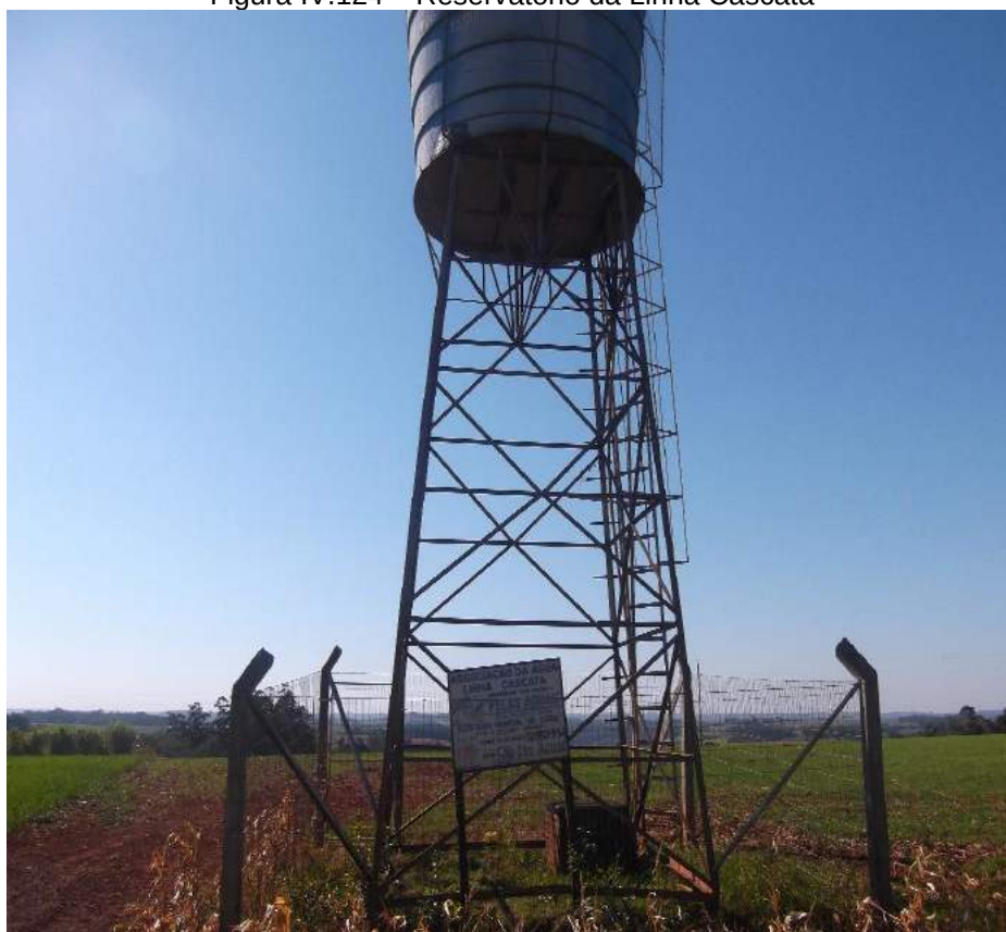
Figura IV.124 – Reservatório da Linha Cascata
