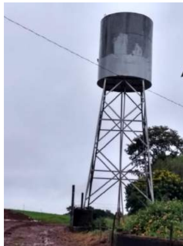
Figura IV.126 – Reservatório da Linha Seção A
