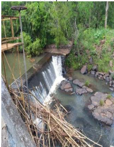
Figura IV.23 – Barramento no manancial de captação
