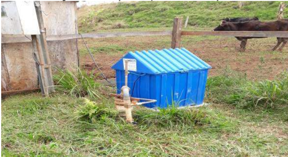
Figura IV.75 – Poço readequado da Linha Seção A
