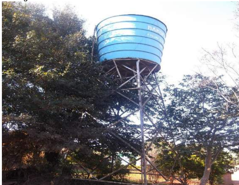
Figura IV.144 – Reservatório da Linha Silva Jardim Sede
