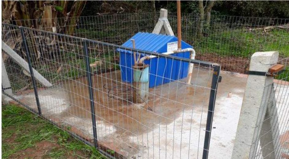
Figura IV.94 – Poço readequado da Linha Paranaguá
