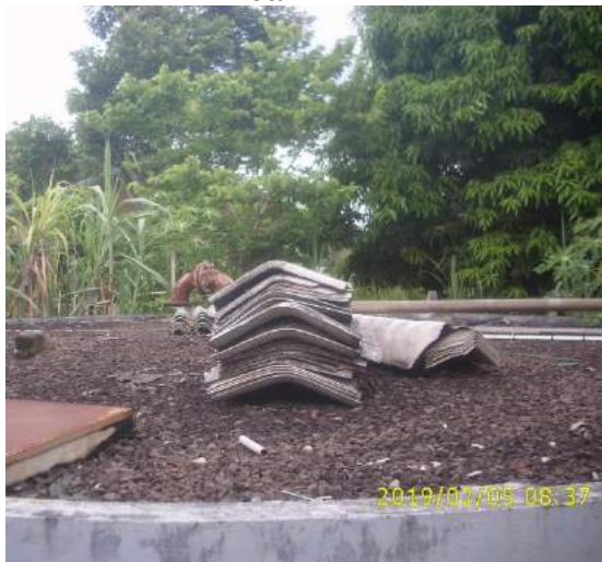
Figura IV.48 – Reservatório semienterrado da ETA
