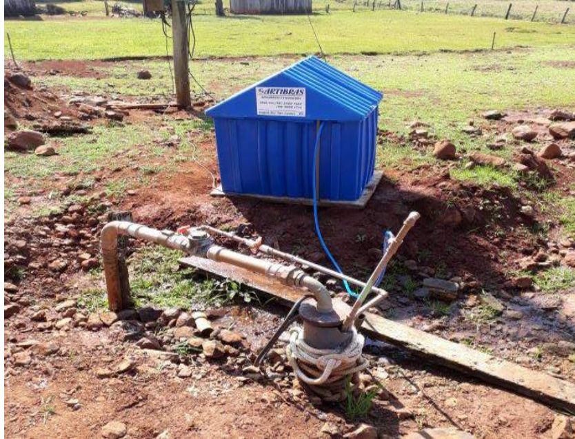
Figura IV.98 – Poço readequado da Linha Acre
