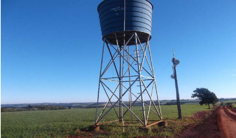
Figura IV.134 – Reservatório da Linha Acre Sul
