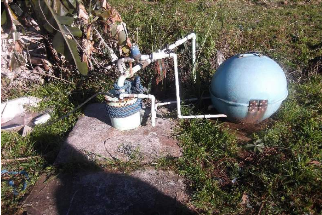
Figura IV.67 – Poço da Linha Dr. Cândido Godói
