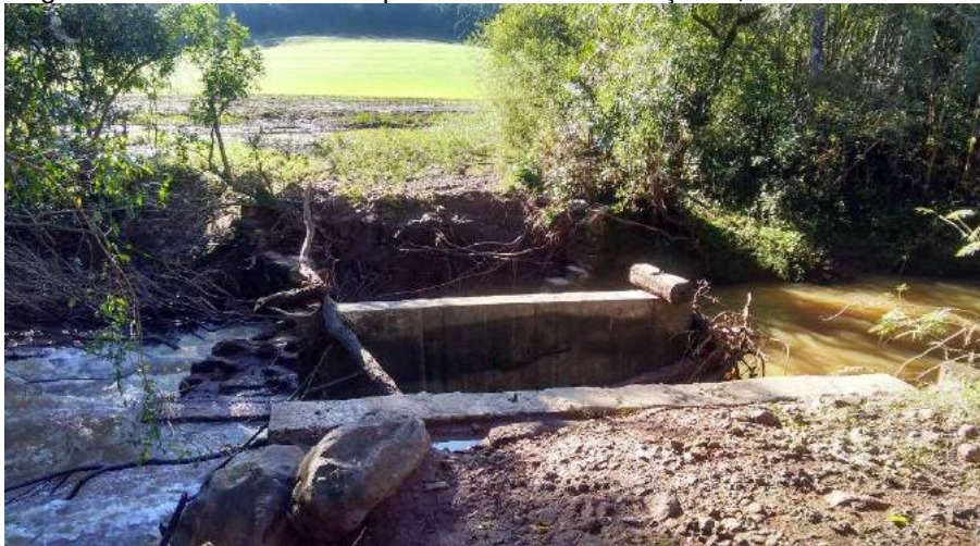
Figura IV.208 - Estrutura de pontilhão na Linha Seção A, em maio de 2017
