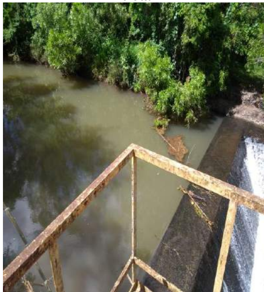
Figura IV.24 - Manancial de captação de água bruta
