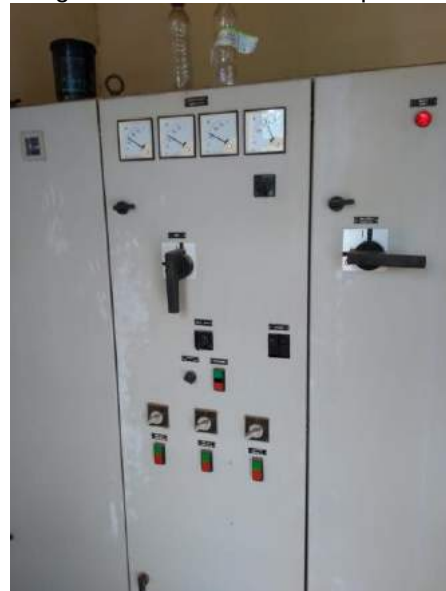
Figura IV.29 – Casa de Máquinas
