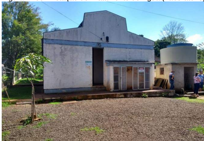
Figura IV.33 - Estação de Tratamento de Água (Laboratório)
