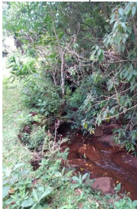
Figura IV.156 - Corpo receptor de esgotos sanitários sem tratamento (afluente do Arroio Tumurupará / Rua Pindorama)
