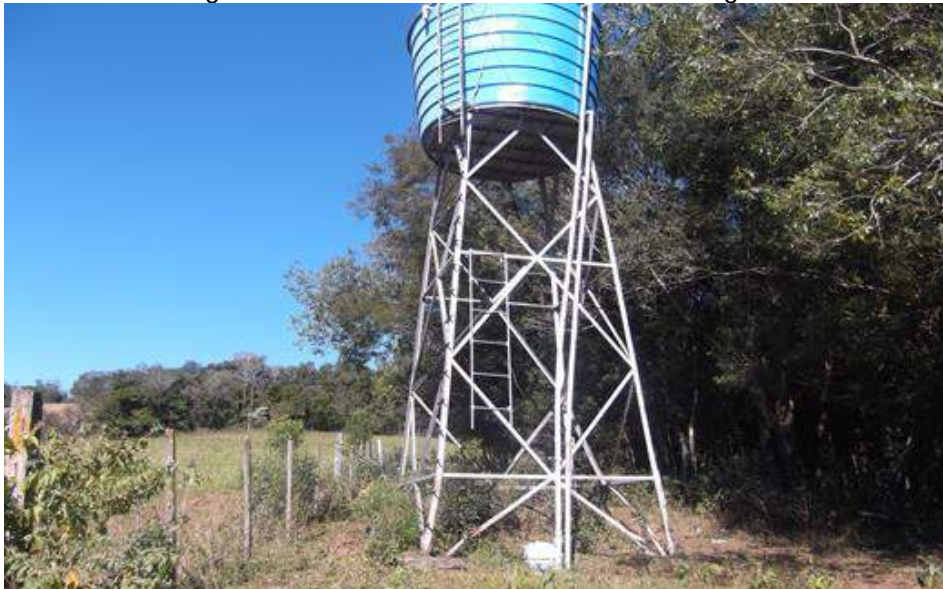
Figura IV.141 – Reservatório da Linha São Miguel
