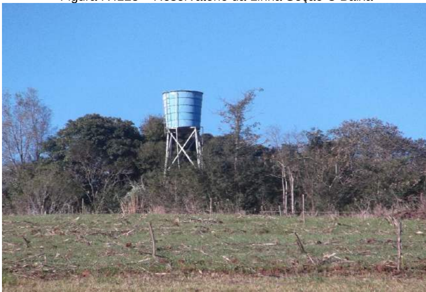
Figura IV.123 – Reservatório da Linha Seção C Baixa
