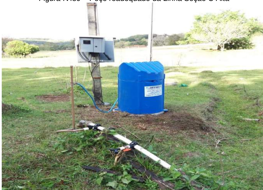
Figura IV.89 – Poço readequado da Linha Seção C Alta
