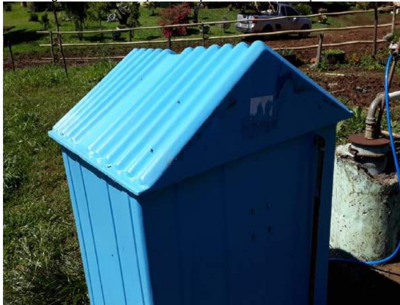
Figura IV.77 – Poço readequado da Linha Seção A Alta
