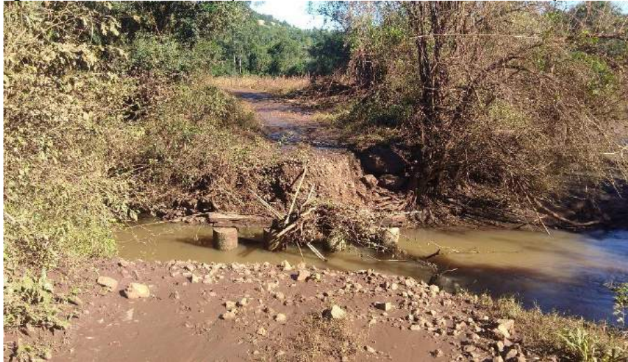
Figura IV.206 - Estrutura de pontilhão na Linha São Pedro, em março de 2017
