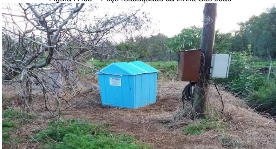
Figura IV.65 – Poço readequado da Linha São João
