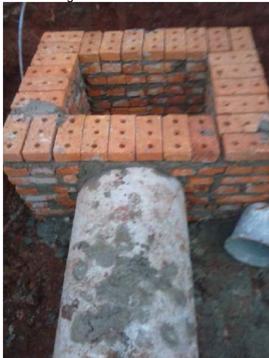
Figura IV.197 - Reforma na rede de drenagem da Rua Loureiro da Silva
