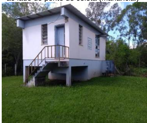
Figura 4-5 Casa de máquinas localizada ao lado do ponto de coleta (manancial)
