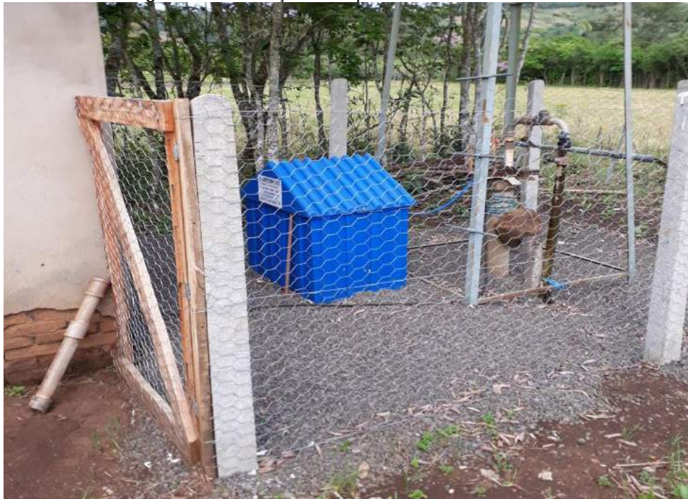
Figura IV.87 – Poço readequado da Linha Boa Vista
